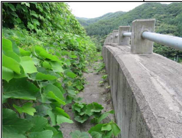
내 용 | 시점부 상단배수로 상태양호
