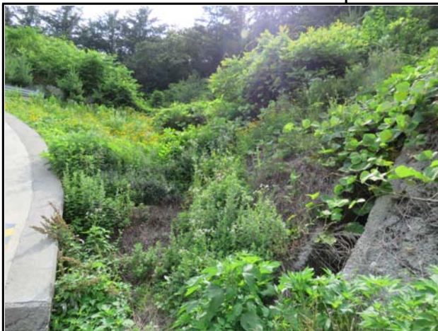
내 용 | 종점부 우측 자연배수형식 사면
