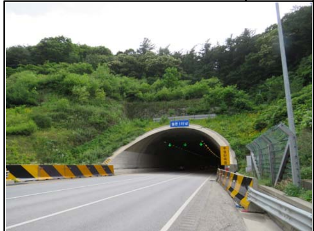
내 용 종점 갱문 시공 현황
