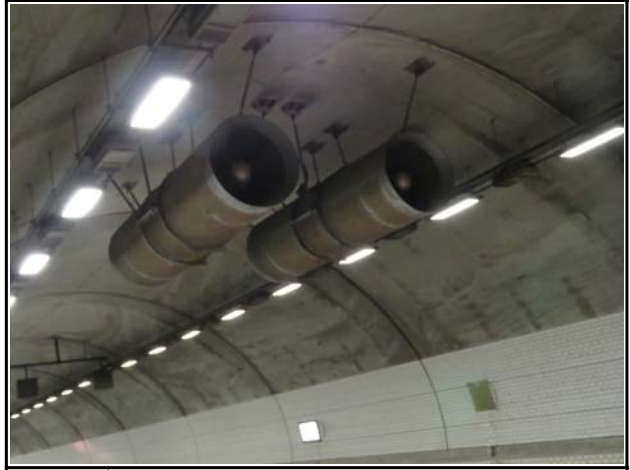
내 용 | 제트팬 상태양호
