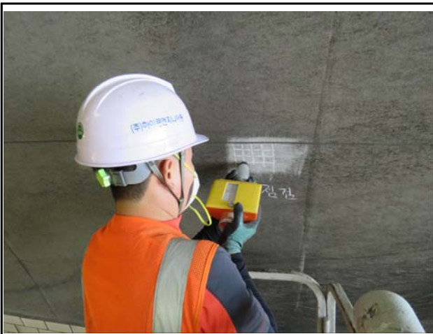
내 용 | 콘크리트 강도측정
