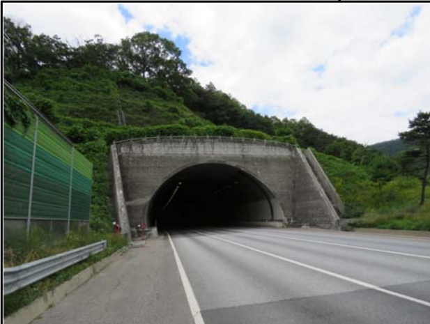
내 용 시점 갱문 시공 현황
