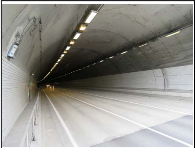
내 용 터널 내부전경
