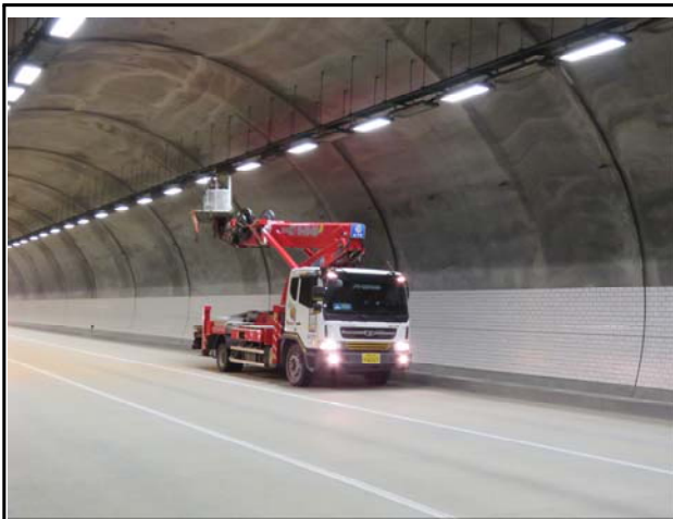
내 용 고소차를 이용한 하부구조 조사
