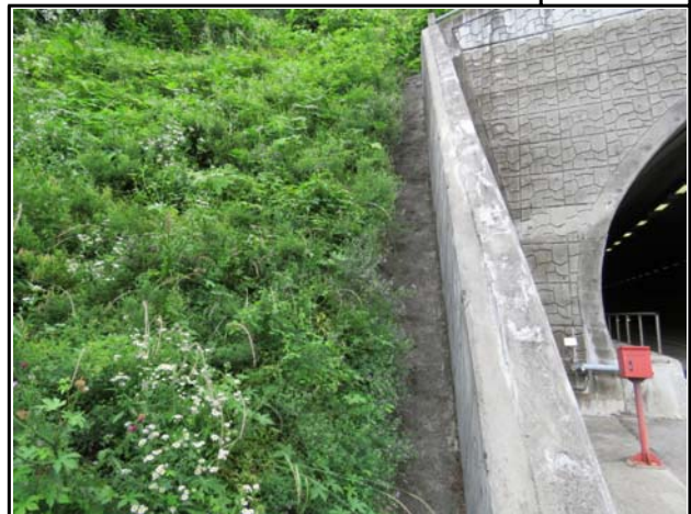
내 용 | 시점부 좌측 배수로 상태양호
