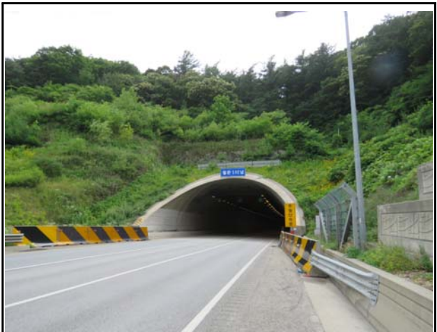
내 용 종점부 갱구부 전경
