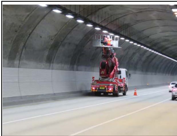
내 용 고소차를 이용한 하부구조 조사
