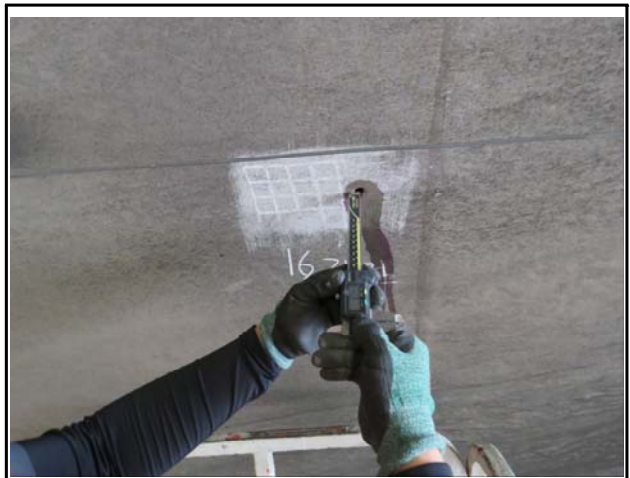
내 용 | 탄산화 깊이측정
