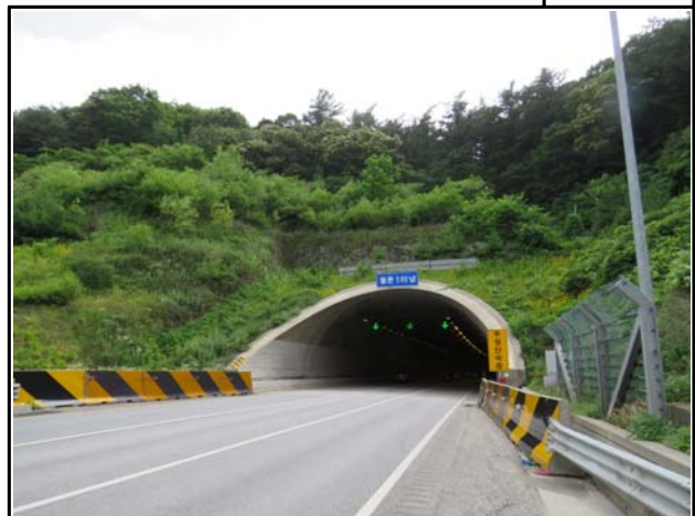
내 용 | 종점부 자연배수형식 사면 전경
